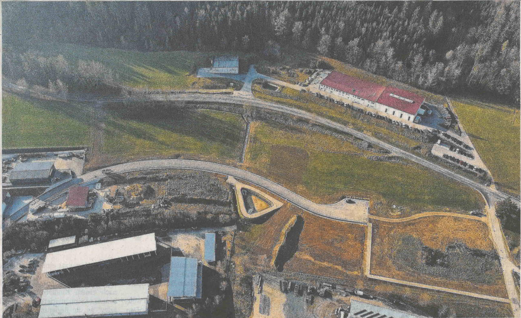
Das ist das neue Gewerbegebiet an der Arnbrucker Straße. Links hat die Firma Haimerl schon gebaut, am unteren Bildrand ist der Kreisbauhof zu sehen. Im oberen Teil endet das neue Gewerbegebiet an der Wettzeller Straße, an die Firma Küppers und die Brennerei Liebl vor Jahren gebaut haben. FOTOS: WF
