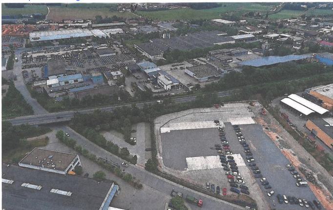
Die Bundesstraße 16 führt durch das Industriegebiet Haslbach. Ab 2023 soll sie von Gallingskofen bis zur Ausfahrt Haslbach vierspurig ausgebaut werden. Deswegen muss auch die Ausfahrt neu gebaut werden. ARCHIVFOTO: LEX
