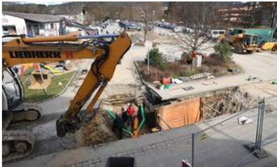
April 2018: Die Baustelle hat den Punkt erreicht, wo die nordwestliche Ecke des AQACUR-Parkplatzes an den östlichen Teil des Spitalplatzes angrenzt. Hier wurden einige der Kanalabläufe bereits zusammengeschlossen. Es steht fest: Das Ziel, bis Pfingsten fertig zu werden, gelingt.
