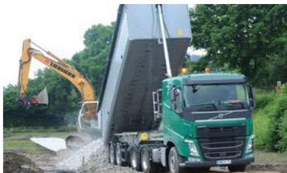
Juni 2016: Die Arbeiten beginnen an der Hammermühle. Die Arbeiten laufen unter Hochdruck, denn im besten Fall soll noch im selben Jahr die Querung unter dem Regen erfolgen, damit im kommenden Jahr der Wasserspiegel nicht mehr abgesenkt werden muss.
