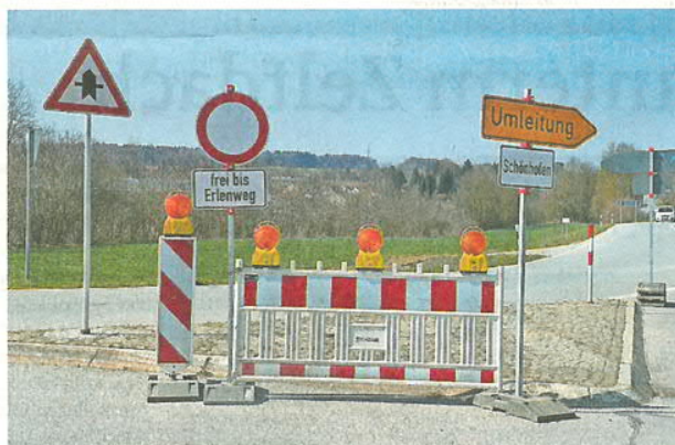
Die Bauarbeiten machen Sperrungen und Umleitungen notwendig.
