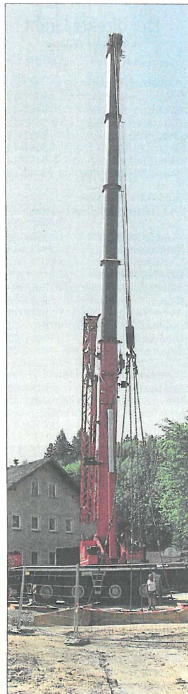
Für die Anbringung des 70 Tonnen schweren Schachtbauwerks war ein Spezialkran erforderlich.
