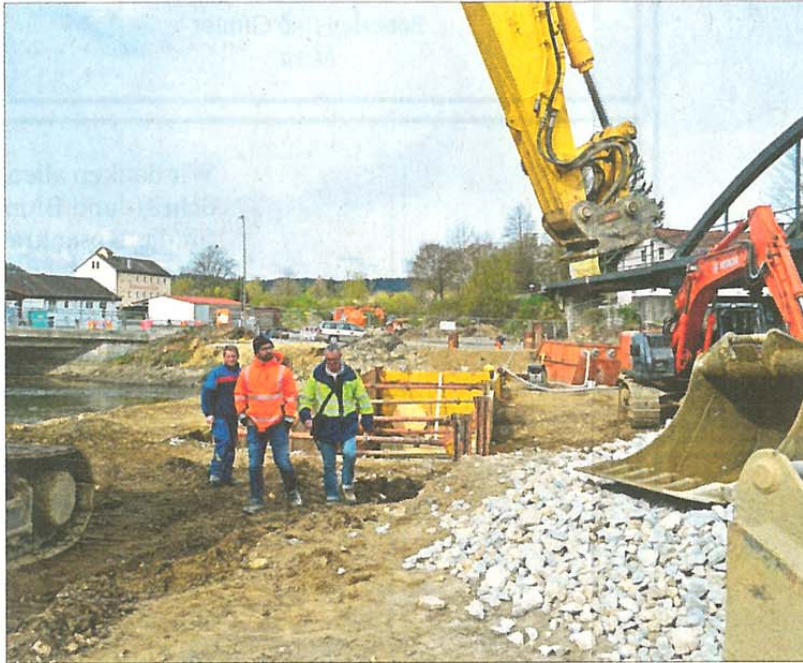
Auf der Baustelle, rechts hinten die Eisenbahnbrücke: Tobias Haimerl, Bauleiter und Chef der ausführenden Baufirma (2. von links) sowie Albert Pinkl, Bauleiter der Planungsfirma EBB (rechts). – Foto: S. Weber
