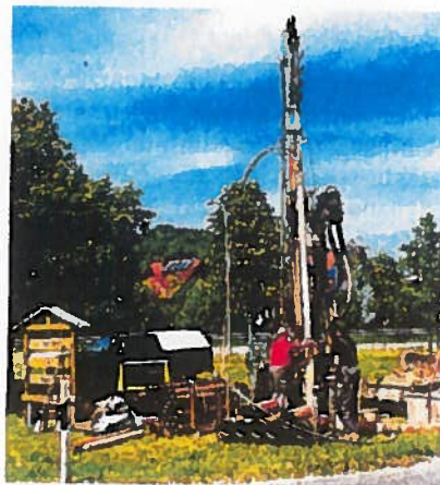
Die ersten Probebohrungen haben begonnen.
