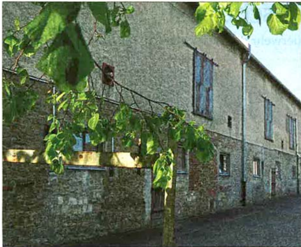
In diesem Gebäude des gräflichen Gutshofs können künftig die barrierefreien Räume des Köferinger Rathauses untergebracht werden. (Fotos: gig)
