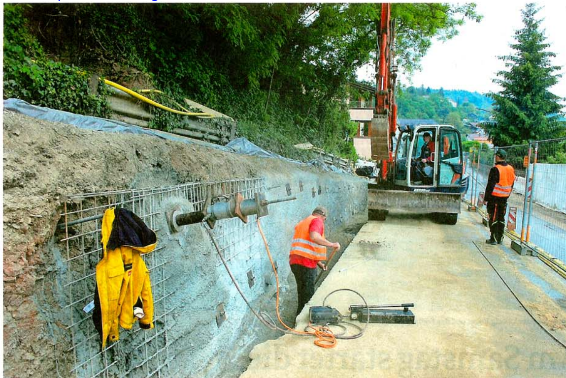
Die Wörther Schlossmauer wird auf einer Länge von 60 Metern saniert. Für die restlichen 300 Meter ist derzeit kein Geld vorhanden.
