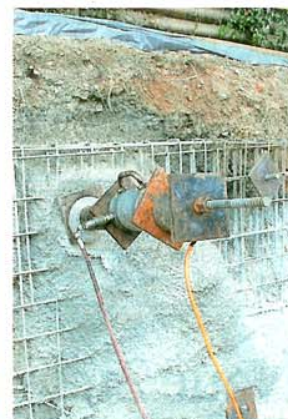
Mit tiefen Bohrungen wird fixiert.
