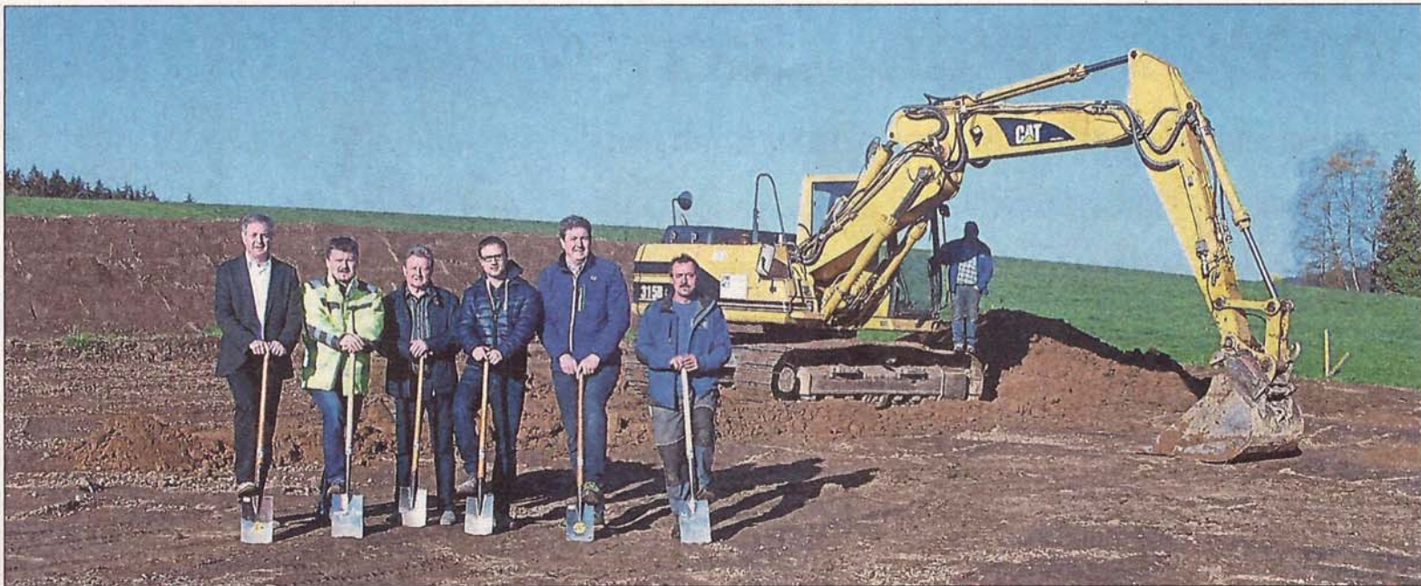
Beim Spatenstich (v.li.) Bürgermeister Werner Blüml, Bauleiter Andreas Steinbauer von der EBB Regensburg, der Kämmerer und Geschäftsleiter der Gemeinde Karl Greil, Ober-Bauleiter Thomas Strohmeier und Bauleiter Thomas Eiter, von der Baufirma Zankl, Polier Hubert Weber und im Hintergrund am Bagger Ägid Schreiner. Foto: Gemeinde
