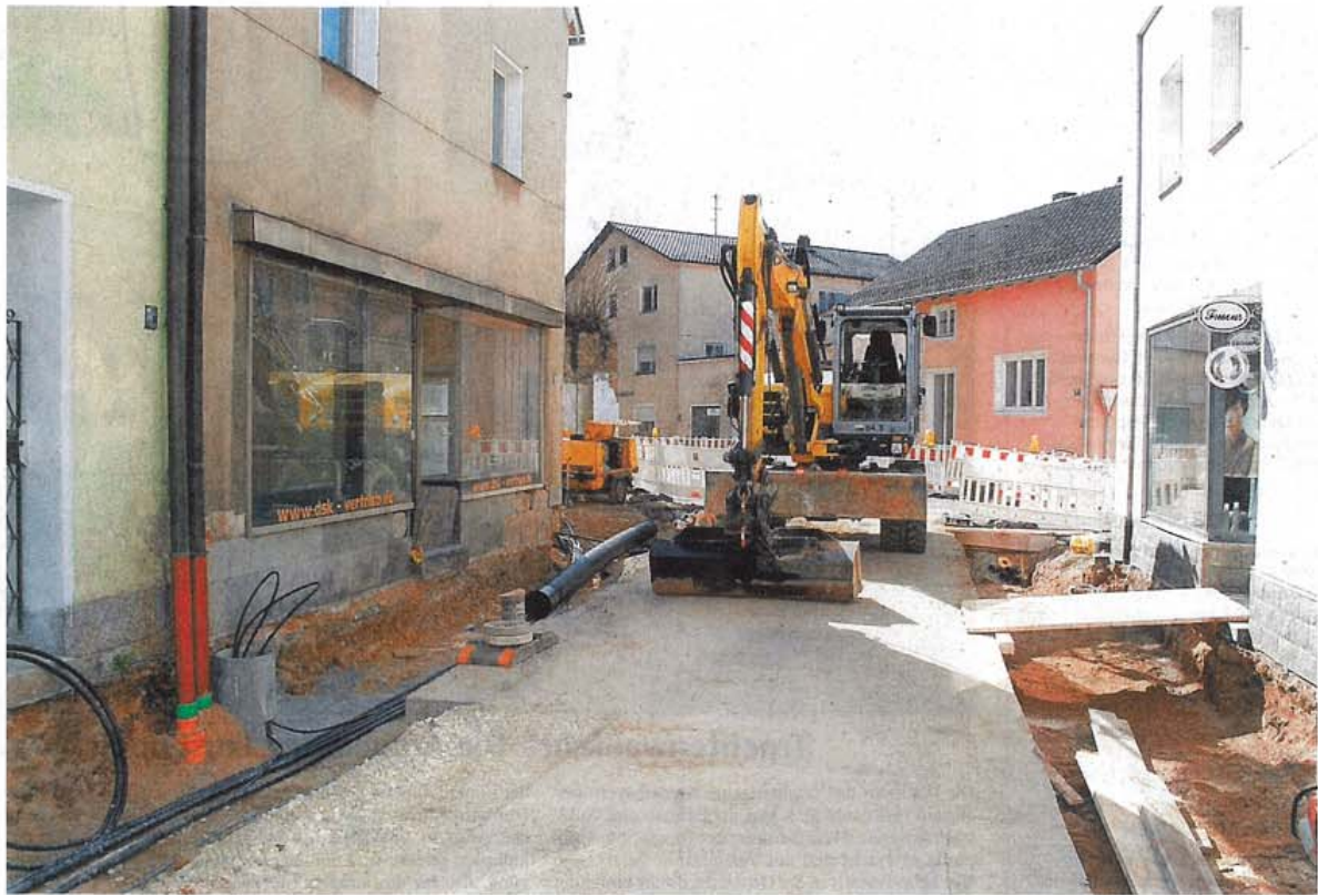
Die Straubinger Straße ist seit vier Wochen eine Großbaustelle. Stück für Stück wurden die Leitungen erneuert, zuletzt wird der Belang dran sein. Fotos: ws
