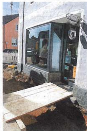
Die Zugänge sind provisorisch.
