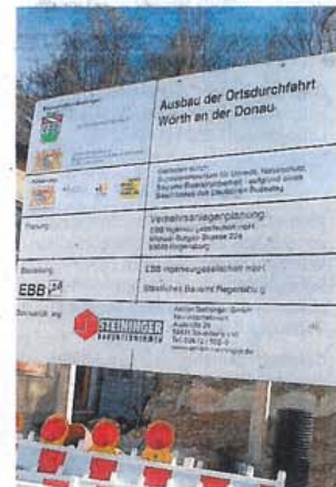
Die Bautafel zeigt die Arbeiten auf.
