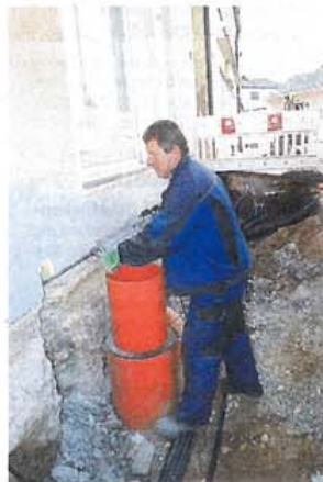
Die Elektrik wird verlegt.
