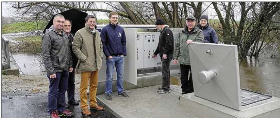
Mit der Fertigstellung der Pumpstation bei Erlauzwiesel kann auch die Abwasserbeseitigung im Bauabschnitt Zimmermandling „ans Netz“ gehen. – Fotos: Draxinger
