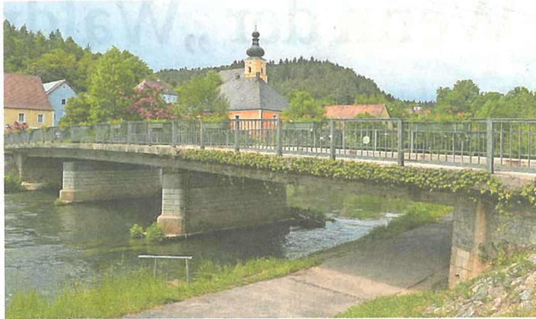
Die Brücke in Dietldorf soll im Frühjahr 2016 saniert werden.
