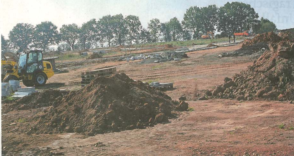
Die Erschließungsarbeiten im Neubaugebiet „Am Kirchengraben“ in Oppersdorf laufen derzeit auf Hochtouren.
