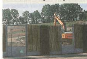
An der Kreisstraße R15 steht bereits eine drei Meter hohe Lärmschutzwand für die künftigen Anwohner.
