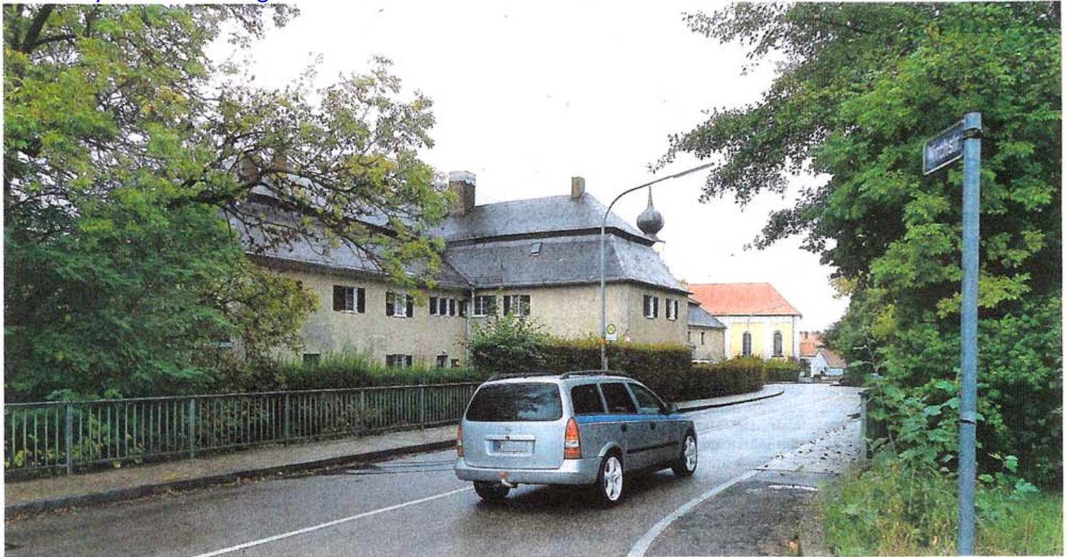
Auch die Mühlbachbrücke weist Schäden auf und muss dringend repariert werden.
