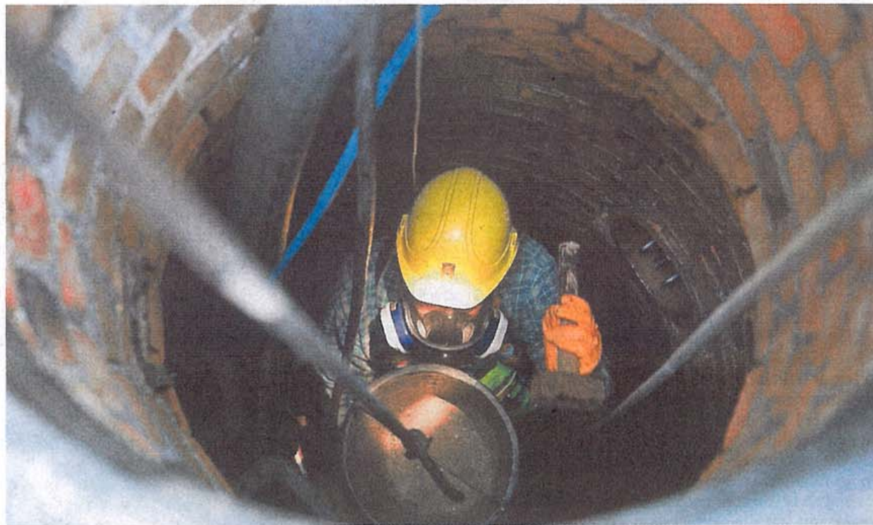
Arbeiten in der Unterwelt: So wie hier muss auch in Sünching der Abwasserkanal saniert werden.
