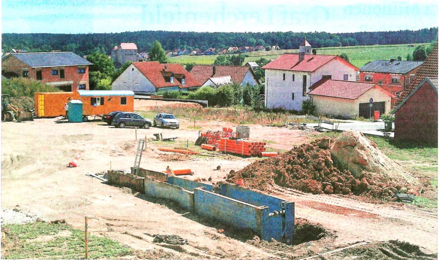
Die Erschließungsarbeiten im Baugebiet „Maisthal-Sillen-Burgblick II“ laufen auf Hochtouren.
