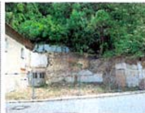
➤ Abbruch: Die Häuser Straubinger Straße 5, 18 und 20 wurden im Zuge der Vorbereitungen des Vorhabens abgebrochen. Die enge Kurve am Beginn der
