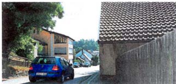
Der Rückbau der Sandmühle, die weit in den Gehsteig hineinragt, kann heuer noch erfolgen.
