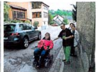
➤ Engstelle: Durch den Rückbau der Sandmühle wird eine gefährliche Engstelle für Fußgänger beseitigt. Rollstuhlfahrer müssen dort in die Fahrbahn aus-
