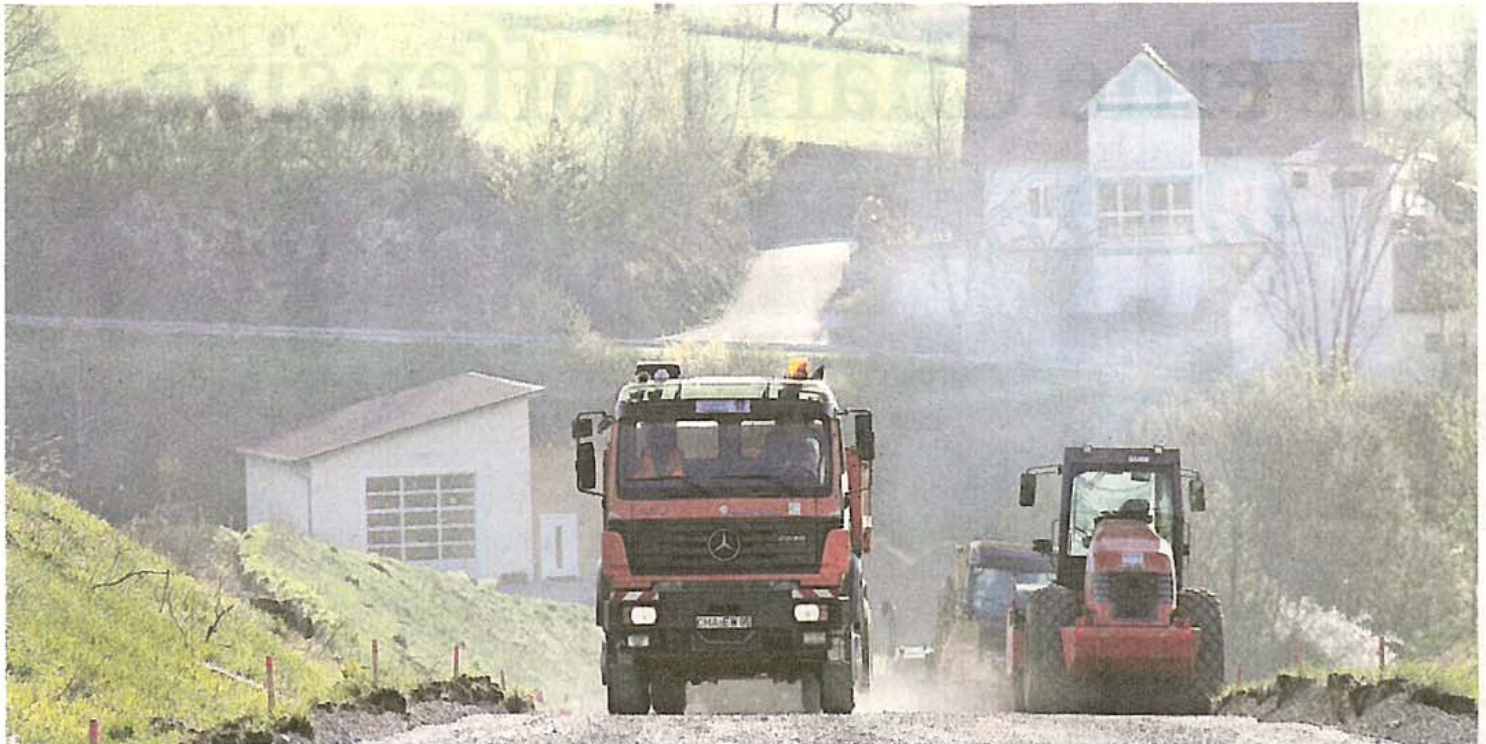
Die Vorbereitungen für den Ausbau der Straße zwischen Bernhardswald und Adlmannstein laufen.
