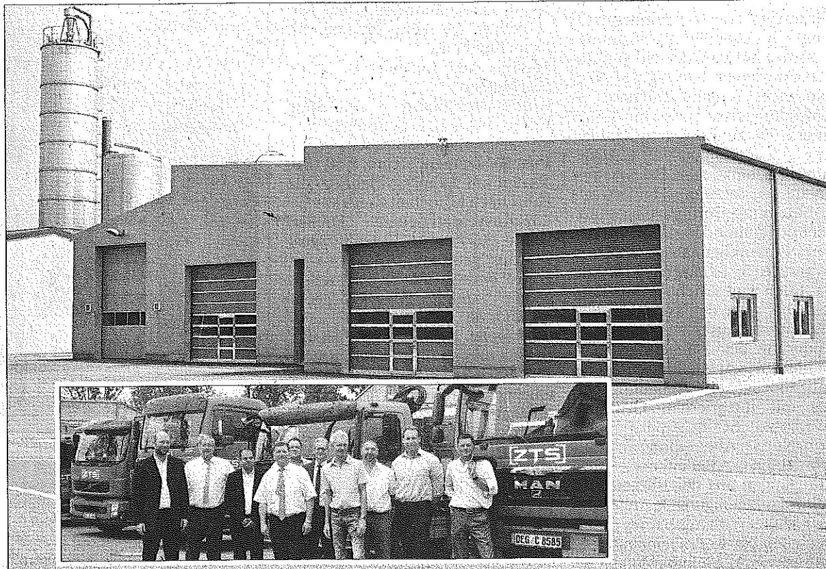
Vor den blitzblank sauberen Lkw der ZTS nach der Einweihungsfeier für die neue Lkw-Werkstatt: (v.l.) evangelischer Pfarrer Johannes Späth, Bürgermeister Erich Schmid, Kaplan Matthäus Palakkeel, Landrat Christian Bernreiter, Robert Besold, Werkleiter Karl-Heinz Kellermann, Helmut Kaiser, Werkstattleiter Rudolf Ertl, Betriebsleiter Stefan Schleicht und Diplom Ingenieur Bernd Strathmeyer (EBB). – Fotos: Hahne/Mejer
