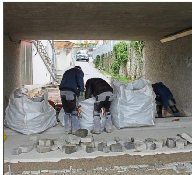
Unter der Fußgängerunterführung an der Regenstraße wird wieder gepflastert, nachdem das Fundament betoniert wurde.
