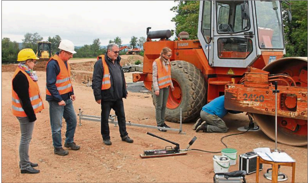
Die Mitarbeiter des Baugrundinstitutes Stephan aus Bad Abbach waren gestern damit beschäftigt, die Verdichtung des Deiches in verschiedenen Versuchen zu überprüfen.
