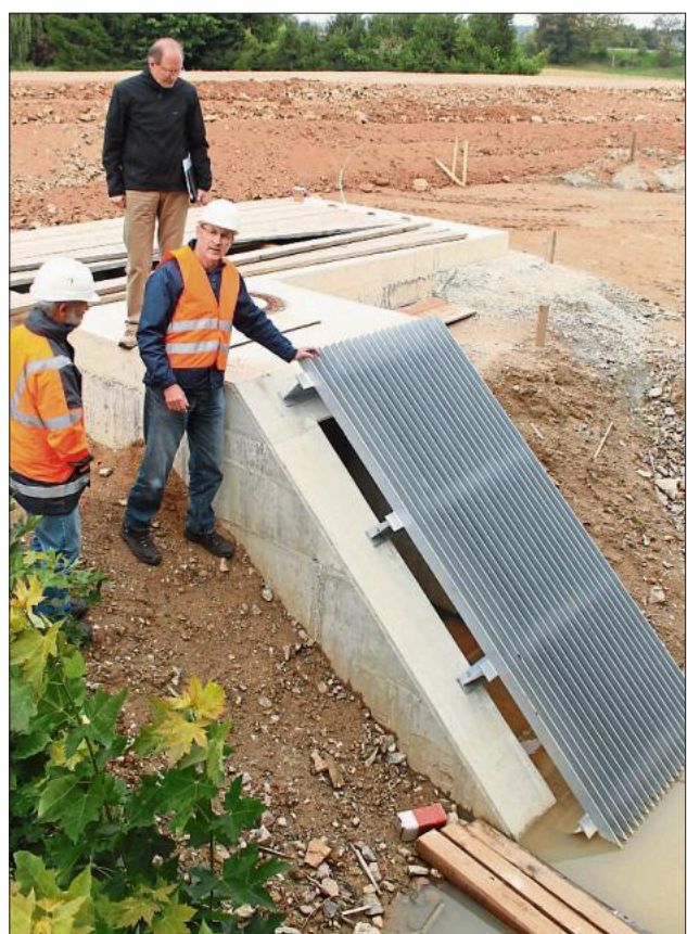
Im Schöpfwerk II, das einen Bach unter dem Deich hindurchführt, fehlen noch Rohre und Pumpen, die bei Hochwasser den Bach trotzdem leiten können.
