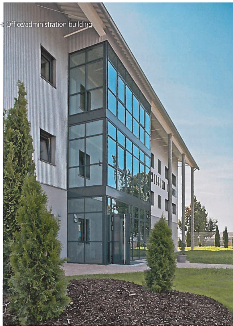
» The three-storey glass annex on the west side of the building houses the foyer and the staircase » Der Glasanbau auf drei Etagen an der Westseite des Gebäudes beherbergt den Empfang und das Treppenhaus
