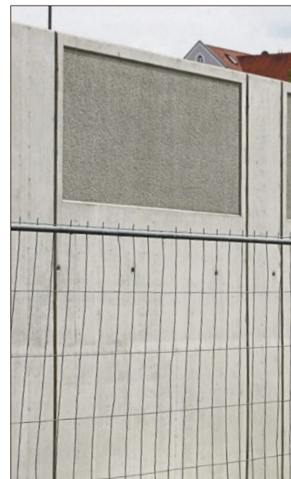
Angedeutete Fenster brechen die Höhe der Hochwasserschutzmauer.
