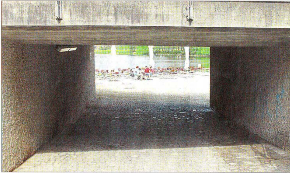
Die Fußgängerunterführung an der Regenstraße/Brücke. Da am Ufer ein Gastronom im Sommer eine Terrasse betreibt, wurde der Torbau auf September verschoben.
