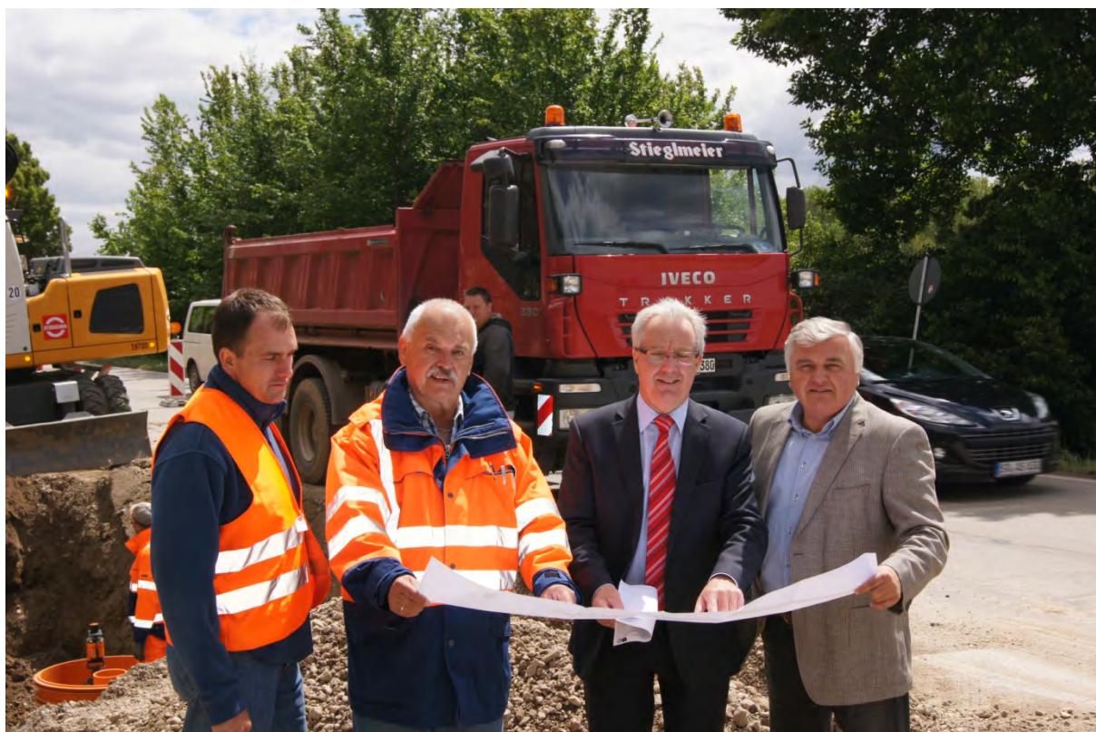
Das Bild zeigt(von rechts): Bürgermeister Ludwig Waas, Gemeinde Niederwinkling , Bürgermeister Franz Schedlbauer, Stadt Bogen, Ing. Tausendpfund - Planungsbüro EBB, Bauleiter Firma Streicher
