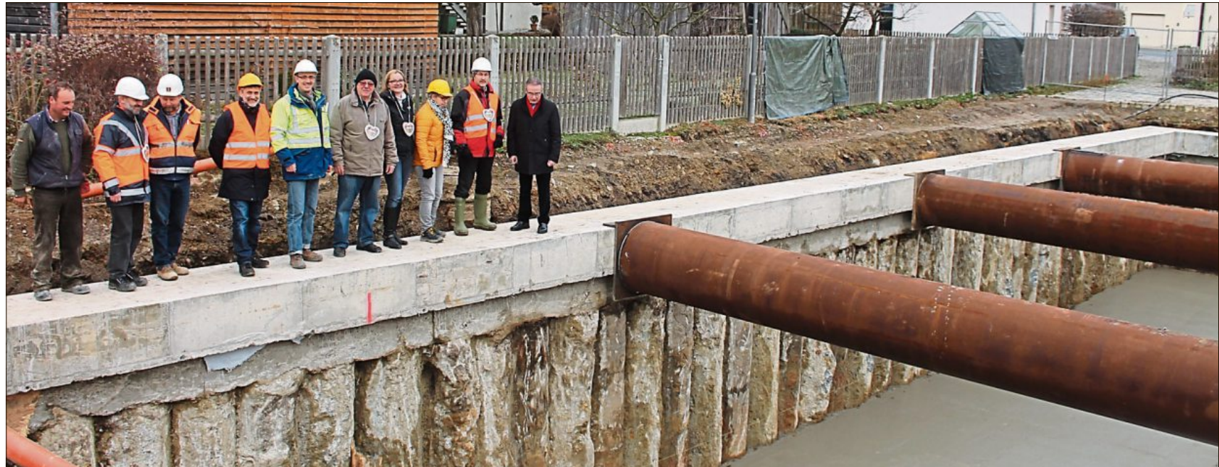
500 000 Liter Wasser wird dieses Regenrückhaltebecken fassen können. Bei einer Besichtigung machten sich Vertreter der Stadt, des Wasserwirtschaftsamtes und der baubeteiligten Firmen ein Bild von den Bauarbeiten.
