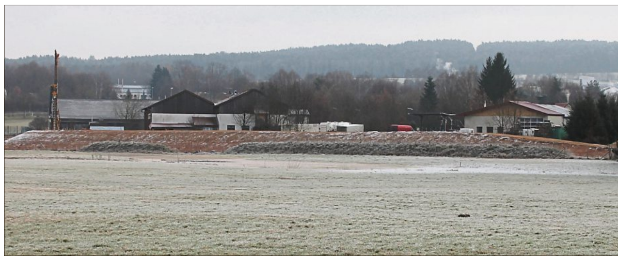
Die Arbeiten am Deich liegen gut in der Zeit. Im Winter kann sich das Material absetzen.
