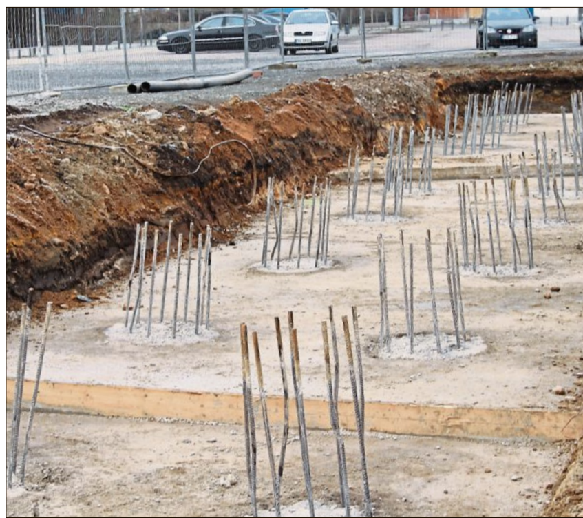
Hier wird ein Teil der Hochwasserschutzmauer entstehen. Die Bohrpfähle rechts und links sorgen für Stabilität – jedoch auch für höhere Kosten.
