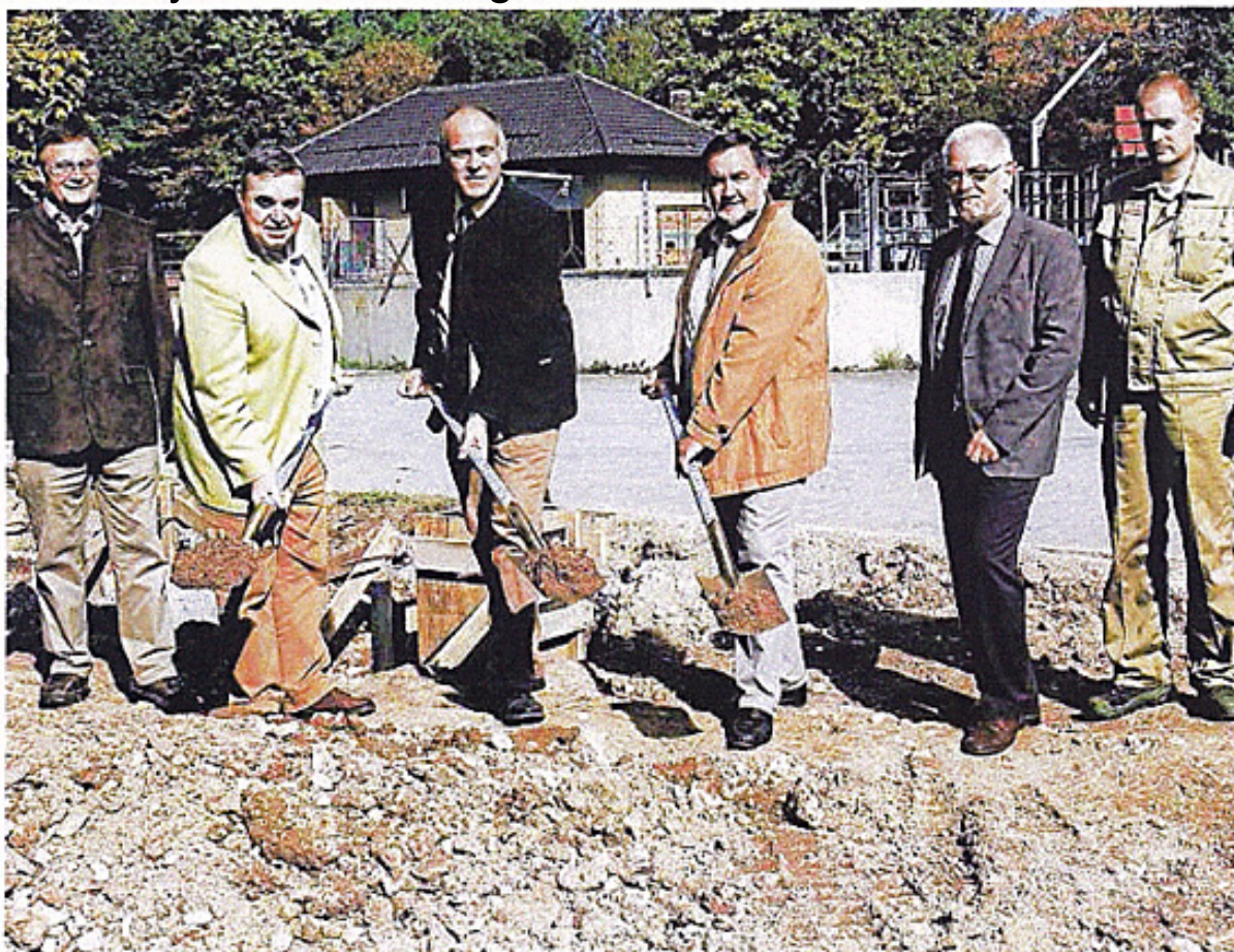
Beim Spatenstich: (Von links) Alfred Fichtl (Zweckverbandsmitglied), Zweckverbandsvorsitzender Anton Rothfischer, Christian Hurka vom Wasserwirtschaftsamt, Otto Thanner, stellvertretender Bürgermeister aus Wiesent, Wolfgang Fries vom Ingenieurbüro EBB und Betriebsleiter der Kläranlage Michael Foerster Foto: Hollender
