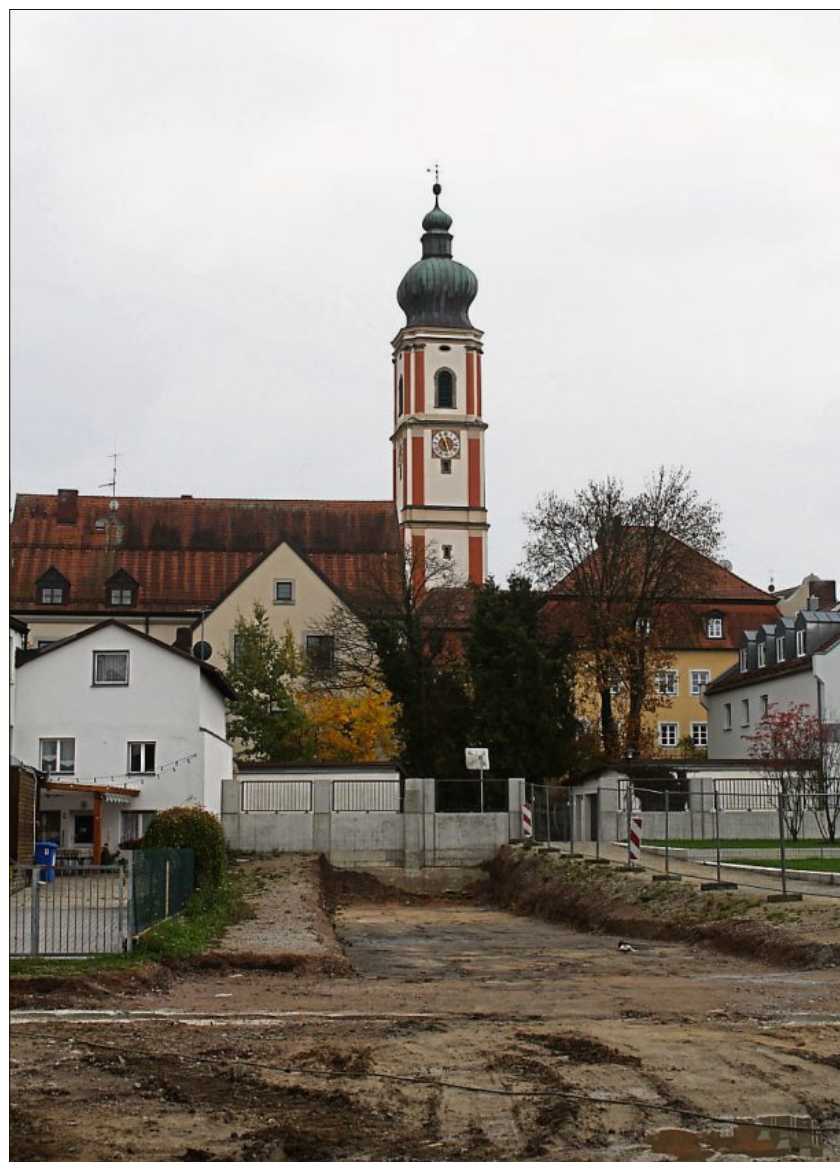
Deutlich zu erkennen ist der ausgeschobene Bereich für die Schutzmauer.
