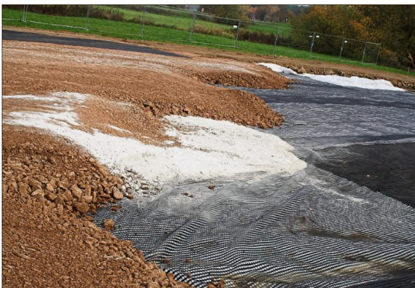
Vlies, Geogitter, spezielle Schüttungen: Der Deich entsteht.
