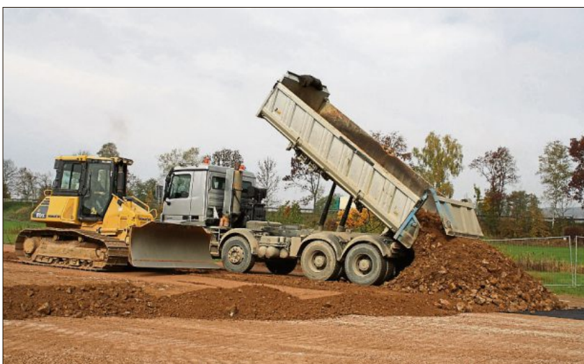
Schwere Kipper bringen Nachschub: Vier Meter hoch wird der Deich einmal.
