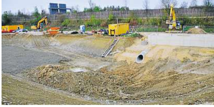
Neben der Autobahn entsteht das Regenüberlaufbecken.
