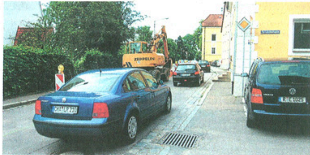
In der Regensburger Straße werden seit gestern die Rohre verlegt. Foto: Schießl
