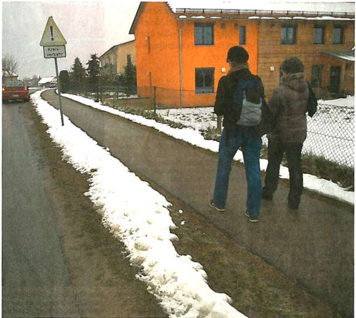
Der bereits bestehende Gehweg beim Altenheim in Bernhardswald
