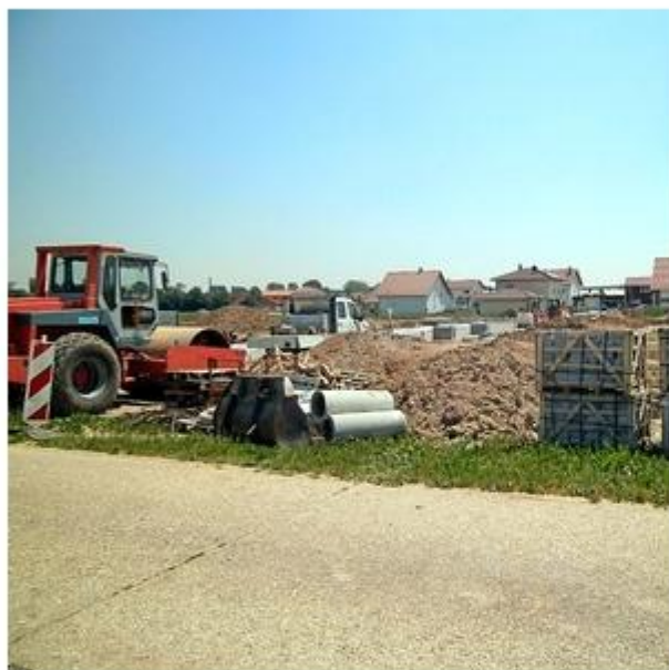
Momentan läuft die Erschließung Höhäcker II. Der Gemeinderat beschäftigte sich in der Sitzung bereits mit dem nächsten Bauabschnitt. Foto Thomann
