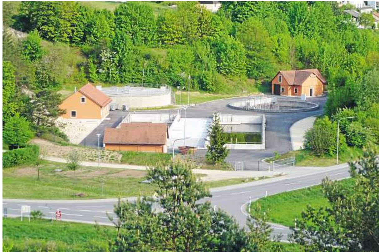
Die modernisierte Kläranlage Undorf erhält am Samstag den kirchlichen Segen.
