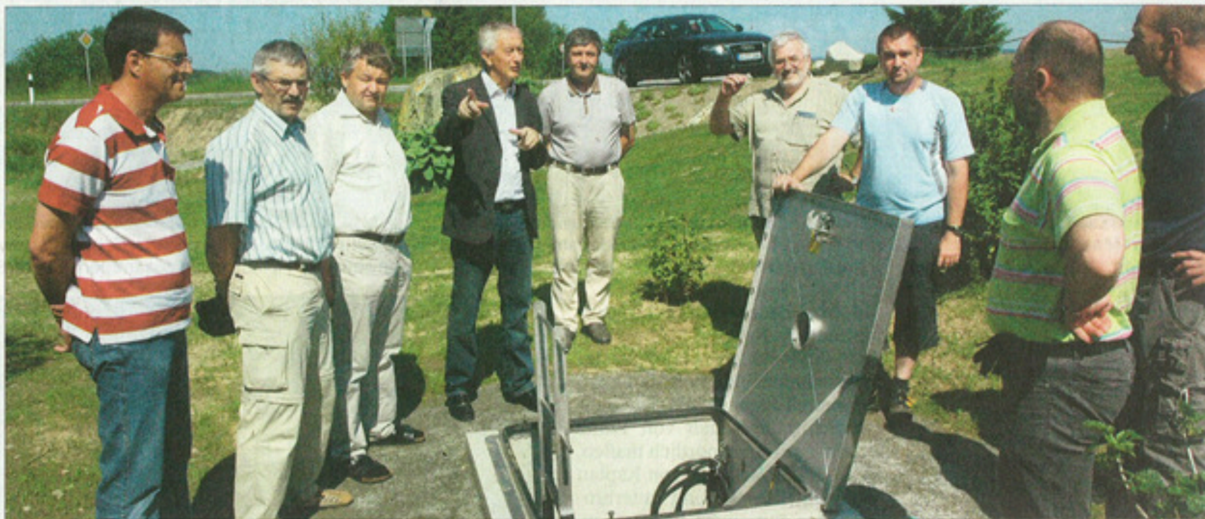
Grünes Licht an der Pumpstation in Erlauzwiesel gaben Ingenieur Bernd Strathmeyer (v.l.), Dr. Albin Schramm und Hermann Pleidl vom Wasserwirtschaftsamt, Bürgermeister Josef Höppler, Bauunternehmer Johann Altendorfer, Bauamtsleiter Manfred Heidl, Hans-Dieter Altendorfer, Kläranlagen-Betriebsleiter Rudolf Kellermann und Bauleiter vor Ort Roland Hackl. – Foto: Klein
