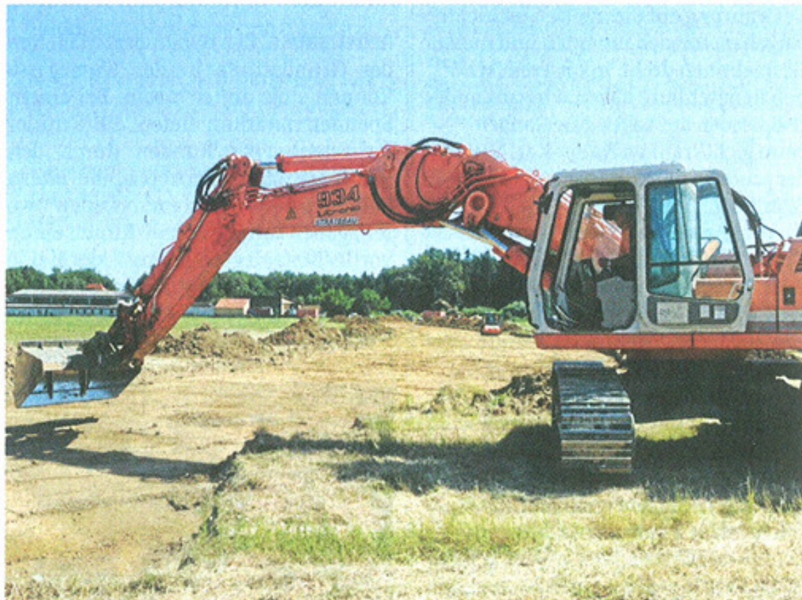
Die ersten Bauarbeiten laufen auf dem Areal des Gewerbegebiets „Pentling Autobahnausfahrt“.
