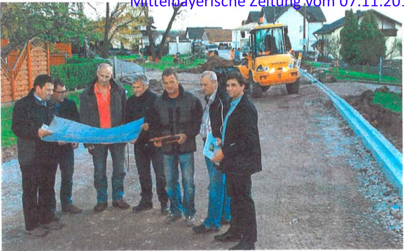
Der Ausbau der Bodenwöhrer Straße befindet sich im Zeitplan, sagen Bürgermeister Thomas Falter, Gerhard Frauenstein und Peter Fuchs (beide EBB Ingenieurgesellschaft mbH), Franz Fenk und Jürgen Reichold von Stratebau sowie Bauhofleiter Johann Spandl und Uwe Knutzen von der Gemeinde (von links nach rechts). Foto: sji
