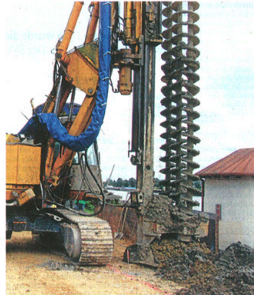
Das MIP-Verfahren: Bohren und Verfüllen gleichzeitig
