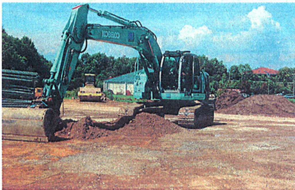
Der Ausweichparkplatz für das Krankenhaus wird jetzt angelegt. Foto: Schießl
