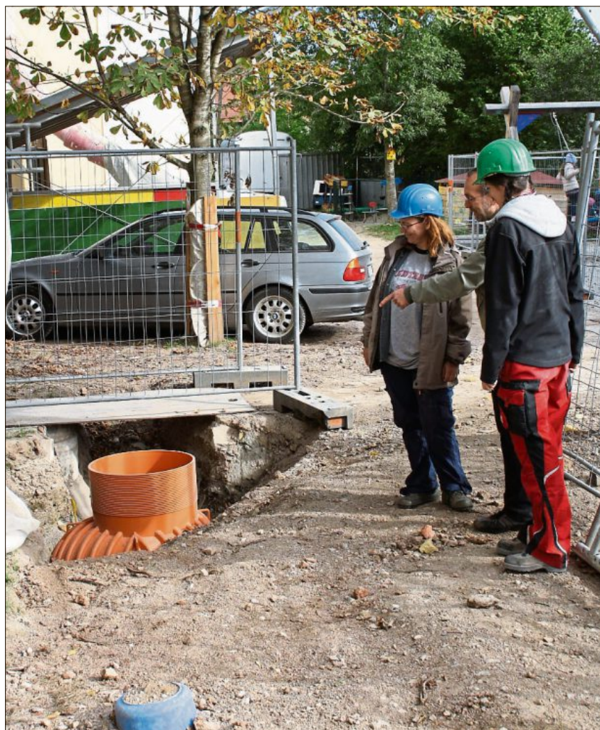
Hier verläuft der Fluchtgang, der inzwischen wieder zugefüllt ist.
