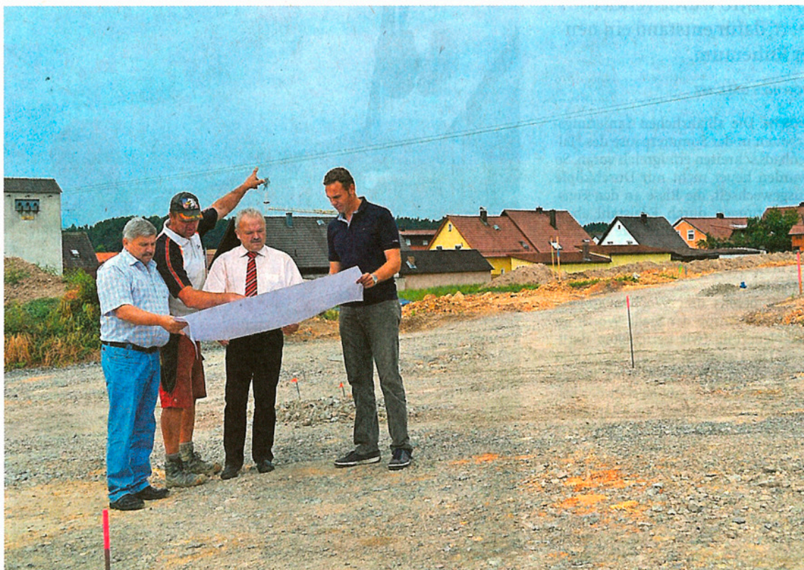
Im kommenden Herbst können im Baugebiet Hohenwarther Straße in Steinsberg die ersten Häuser gebaut werden. Unser Foto zeigt 2. Bürgermeister Hans Dechant (zweiter von rechts) und Abwasserzweckverbands-Vorsitzende Fritz Dechant bei einem Ortstermin im Baugebiet.
